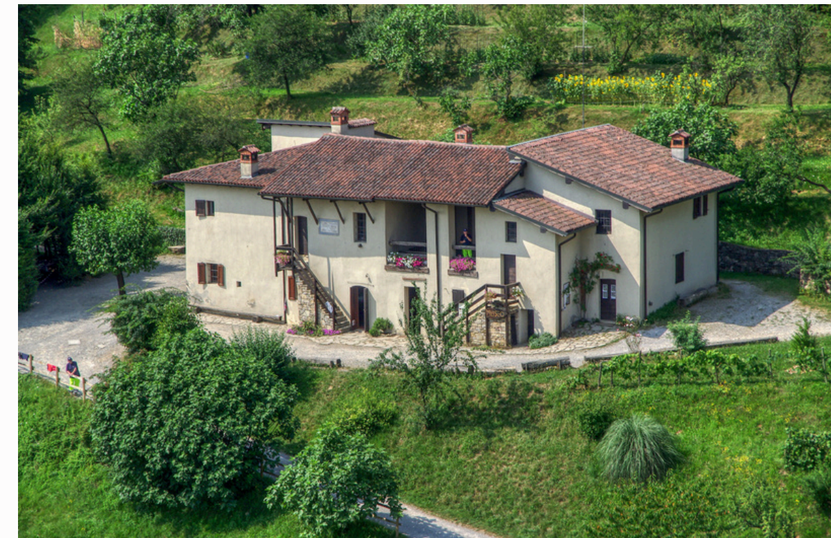
CENTRO PARCO Ca' del Soldato: Via Bagaggera - La Valletta Brianza (LC)
